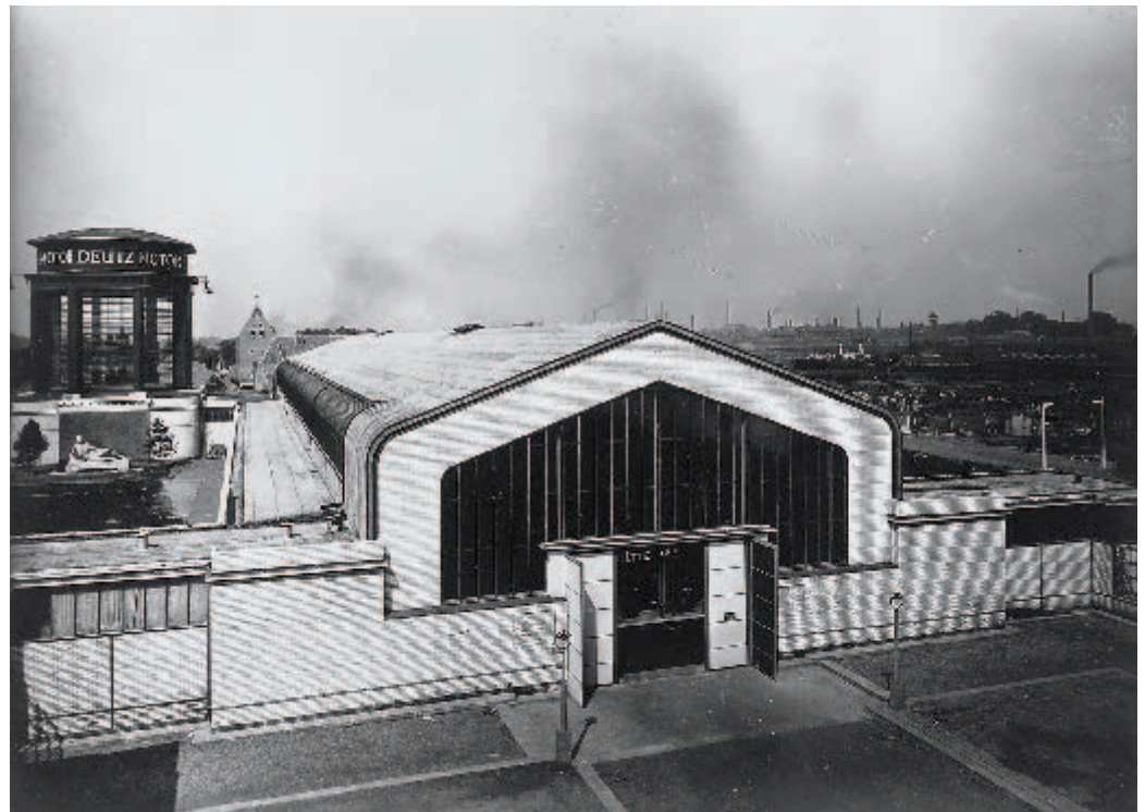
Walter Gropius mit Adolf Meyer, Maschinenhalle und Deutz-Pavillon für die Werkbund-Ausstellung, Köln. 1914, Fotograf unbekannt, BHA. ● Die raumbildende und das Gebäudevolumen kennzeichnende Stahlbinderkonstruktion wird auf der Fassade sichtbar zum Ausdruck gebracht.
